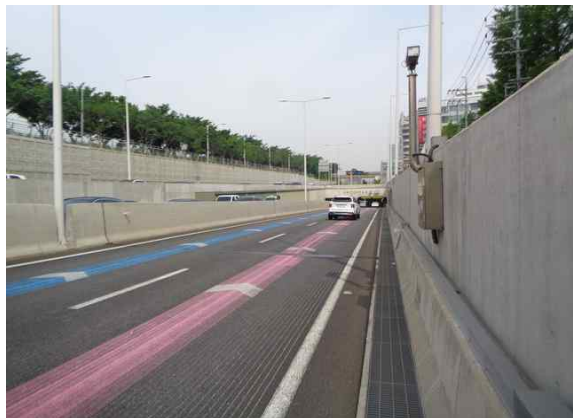
서부간선지하도로 성산방향 진입부
